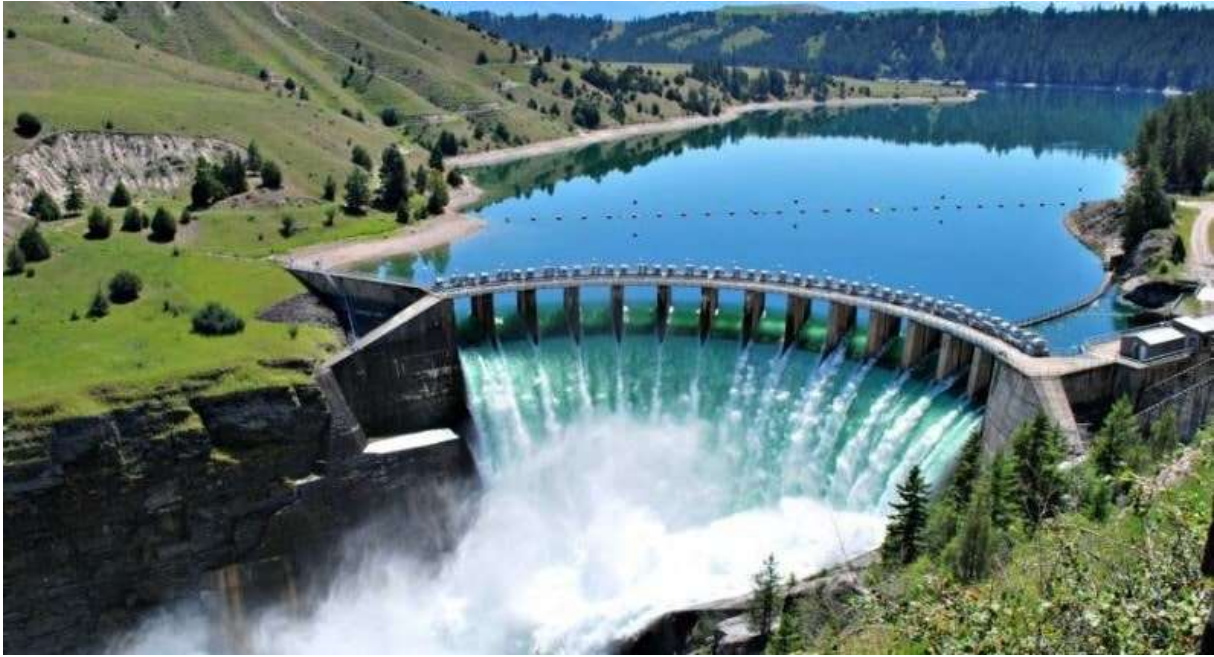
Hidroelektrik Enerji Santrali
