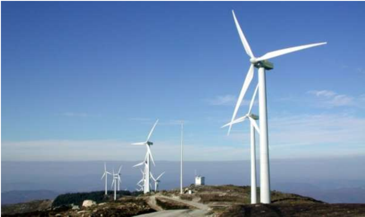
Rüzgâr Enerjisi Santrali
